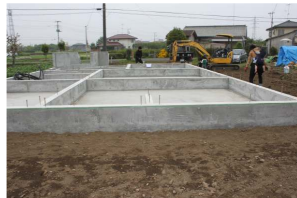
基礎が打ち上がる(西側)
