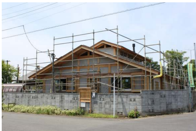
東面の外観を見る
