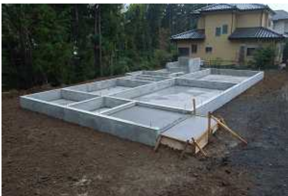
一体打基礎で建て方を待つ
